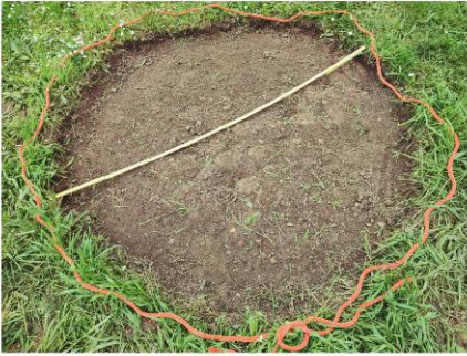
1. Grube abmessen und ausheben
